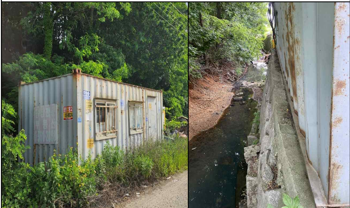
현장사진(공유수면 무단 점유-컨테이너)
