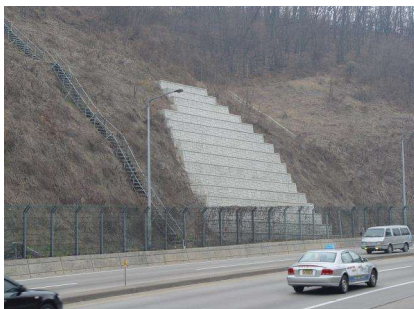
[그림 3-12-12] 비탈면 보강을 위한 계단식 옹벽 지양 사례
