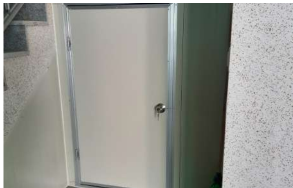
1층 계단 밑 창고 설치
