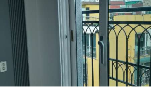
거실문 손잡이 설치
