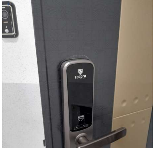
디지털 자동 도어록은 레버 일체형으로 설치
