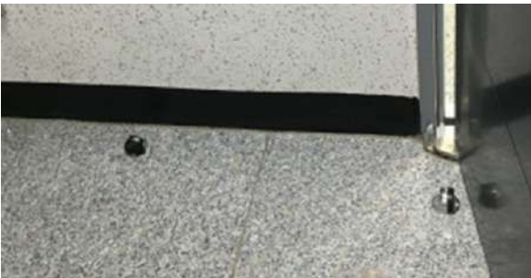
현관문 반달스토퍼 설치
