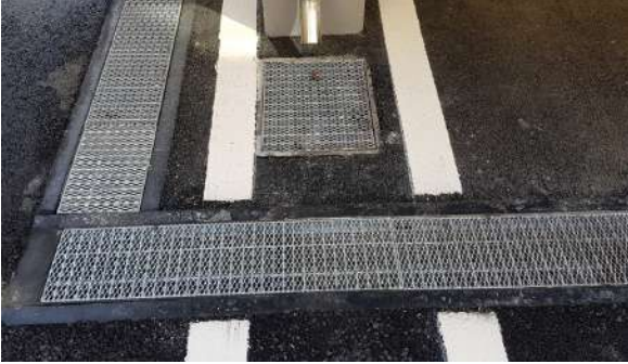
배수구 트렌치 거름망 설치
