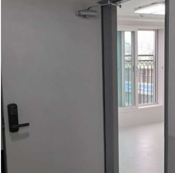
현관문이 자동적으로 천천히 닫힐 수 있도록 도어체크 설치
