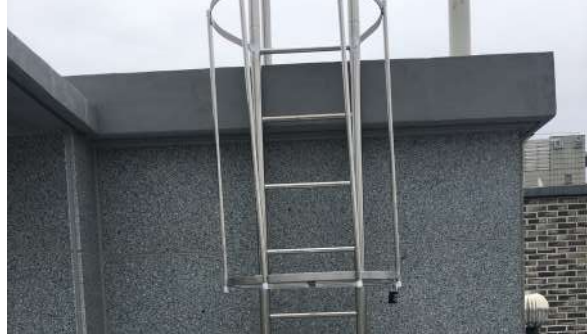
옥탑 점검용 사다리 설치 (시건장치 포함)
