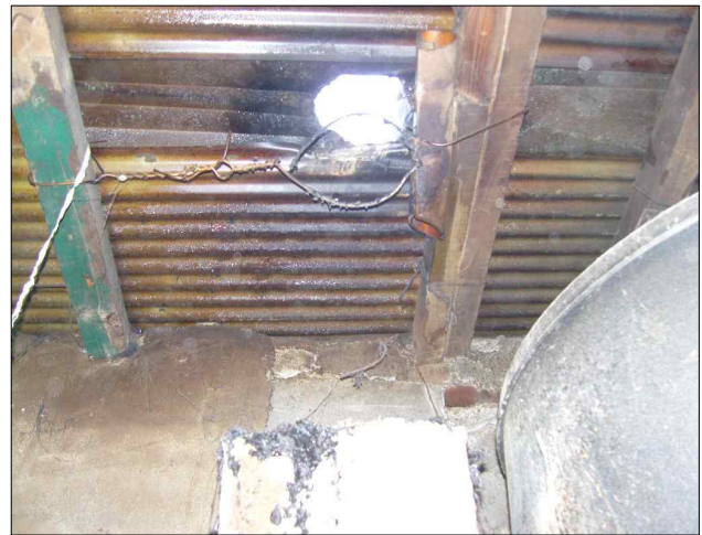
사진 3-1. PVC재질 연통이 녹아내린 잔해물과 보일러 연통이 외부로 통하는 지붕 소훼상태
