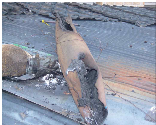
사진 3-2. 연통이 관통하는 지붕 위와 주변 연통이 소훼된 사진
