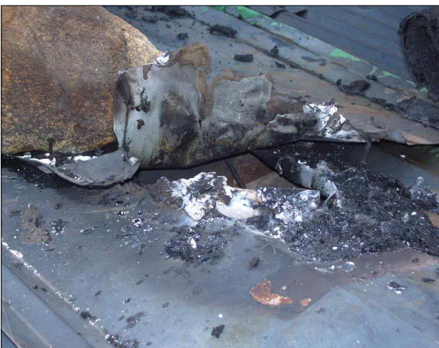
사진 3-2. 연통이 관통하는 지붕 위와 주변 연통이 소훼된 사진
