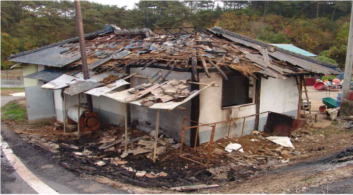
1-1. 주택 외벽에 설치된 화목보일러에서 주택상부로 연소 확대된 상태
