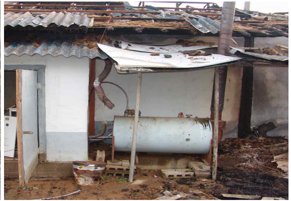
1-1. 주택 외벽에 설치된 화목보일러에서 주택상부로 연소 확대된 상태
