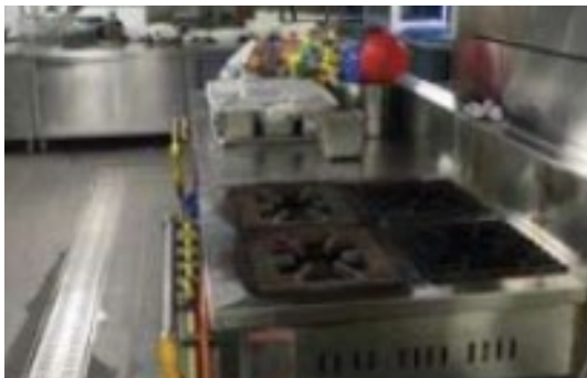
▲ 미신고 증축 조리장 전경
