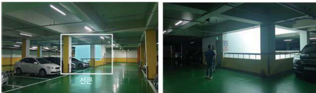
〈그림 28〉 선큰이 설치된 지하주차장
