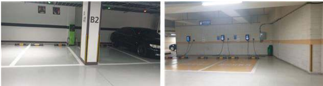
〈그림 34〉 충전구역 미표시(좌), 충전구역 표시기준과 다른 색상(우)
