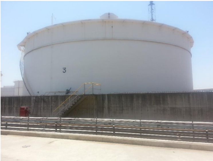
SK인천석유화학의 옥외 탱크 방유제
